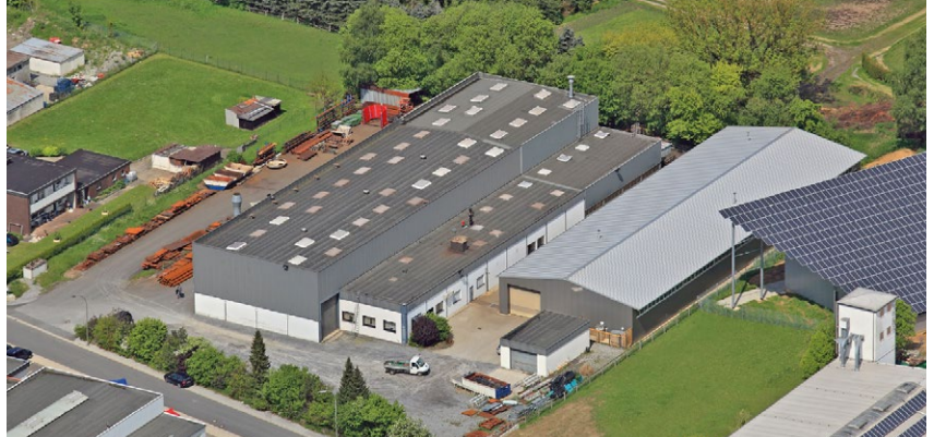
Am Unternehmenssitz in Rüthen werden nach Kundenzeichnungen komplette Anlagen und Sondermaschinen gefertigt. Foto: ACCENT Metalltechnik GmbH
